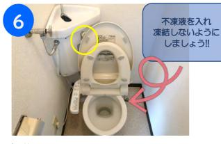
【黄色O】タンク内の水が無くなるまでレバーを回します。 (レバーを固定するロックボタンを押します)
